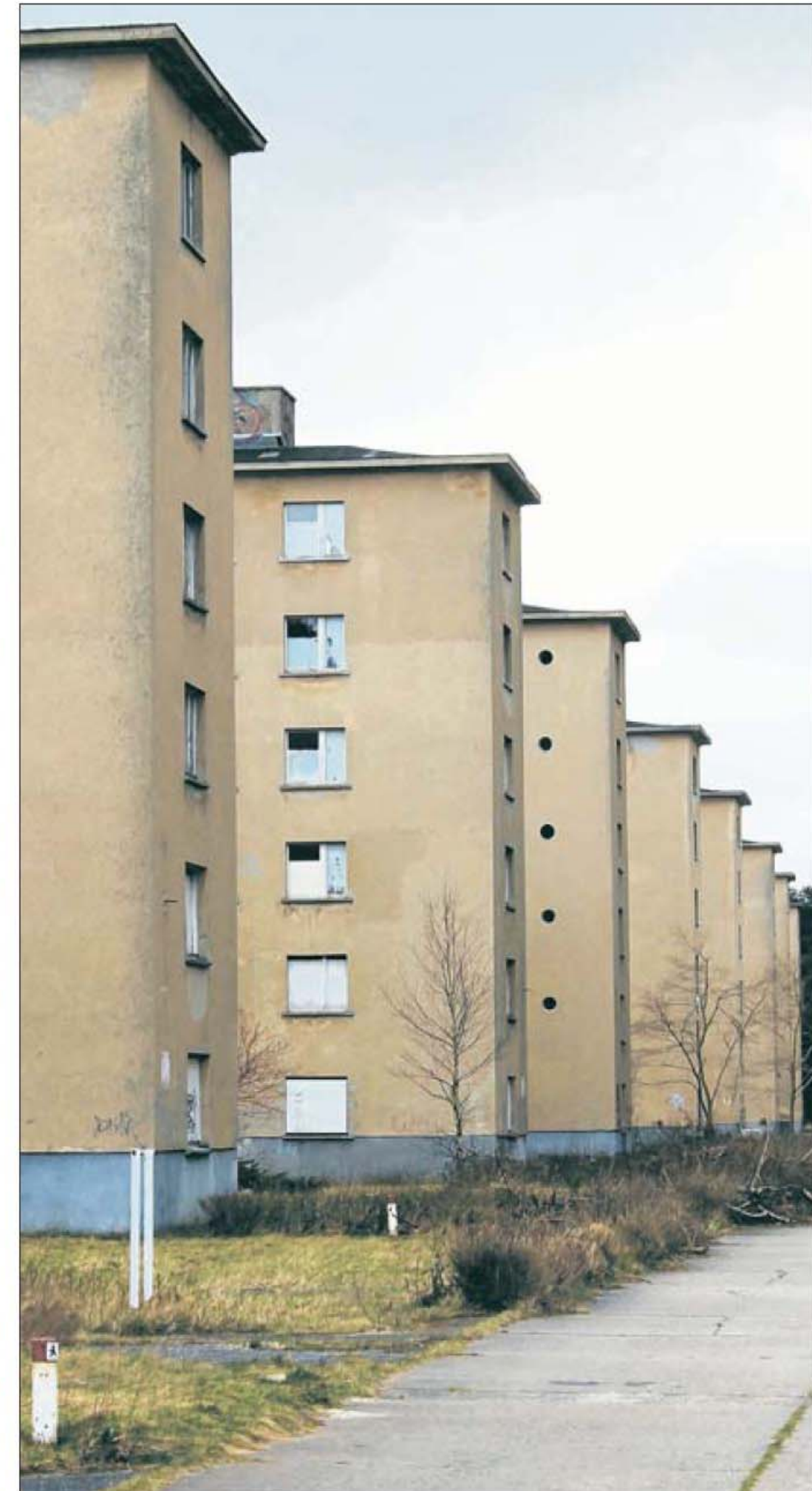
Blick auf die Treppenhäuser von Block I des ehemaligen „Kraft-durch-Freude“-Bades der Nazis in Prora auf Rügen. Foto: dapd
