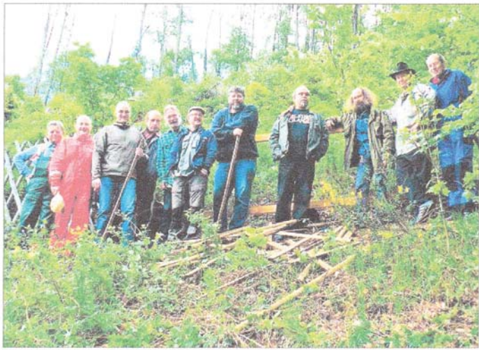
Die ehemaligen Bausoldaten, die sich für ihr diesjähriges Treffen die Stadt Suhl ausgesucht haben, legten im Tierpark tüchtig Hand an und reparierten den 70 Meter langen Außenzaun.
