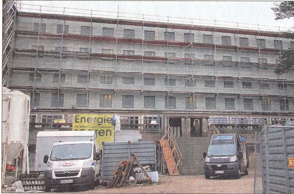
Immerhin 840 Fenster müssen eingesetzt werden, darauf liegt die Konzentration bei den Arbeiten durch die entsprechende Fachfirma derzeit. Foto: Schmidt
