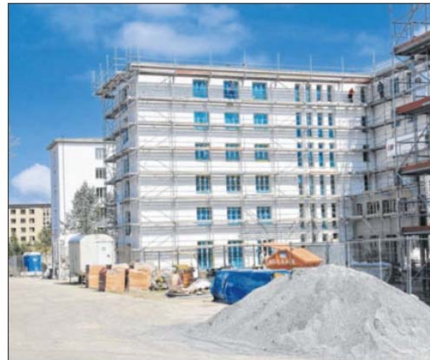
Block IV mit seinen bereits fertigen Mietwohnungen und noch im Bau befindlichen.
