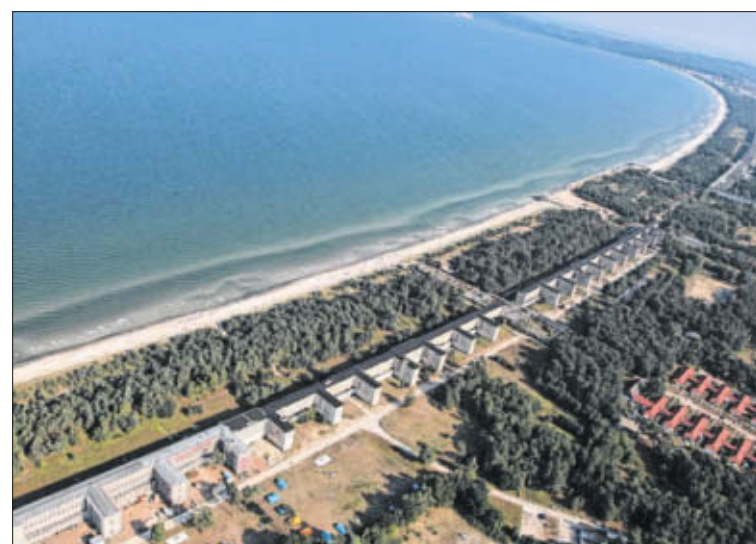
Dicht am Wasser gebaut: Luftbild der Anlage zu Beginn der Sanierungsarbeiten. Foto: Christian Ródel
