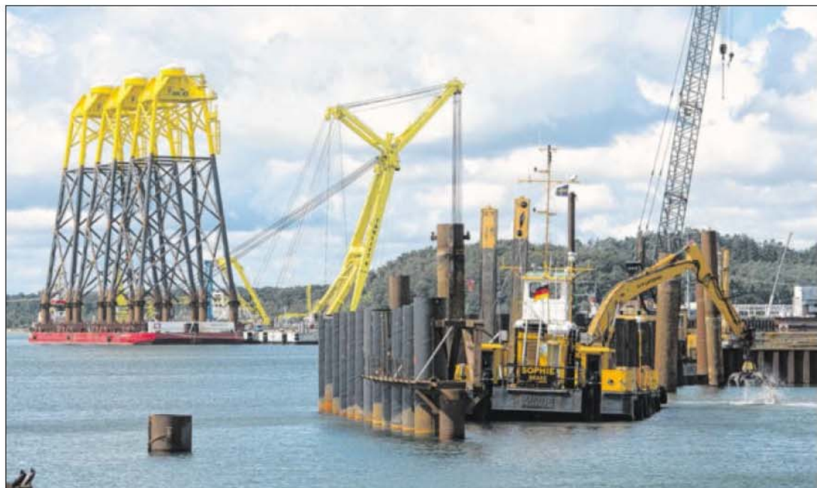
Ein Spezialschiff hat riesige Stahlmasten, so genannte Jackets, für die Windkraftanlagen des Offshore-Parks Wikinger in Mukran an Bord genommen, um sie zur Baustelle in der Ostsee vor Rügen zu bringen. Im Vordergrund wird gebaggert. Der Hafen wird für die Offshore-Industrie weiter ausgebaut. Fotos: Stefan Säuer
