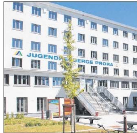
Saniert und dennoch Baumängel: die Jugendherberge Prora.
