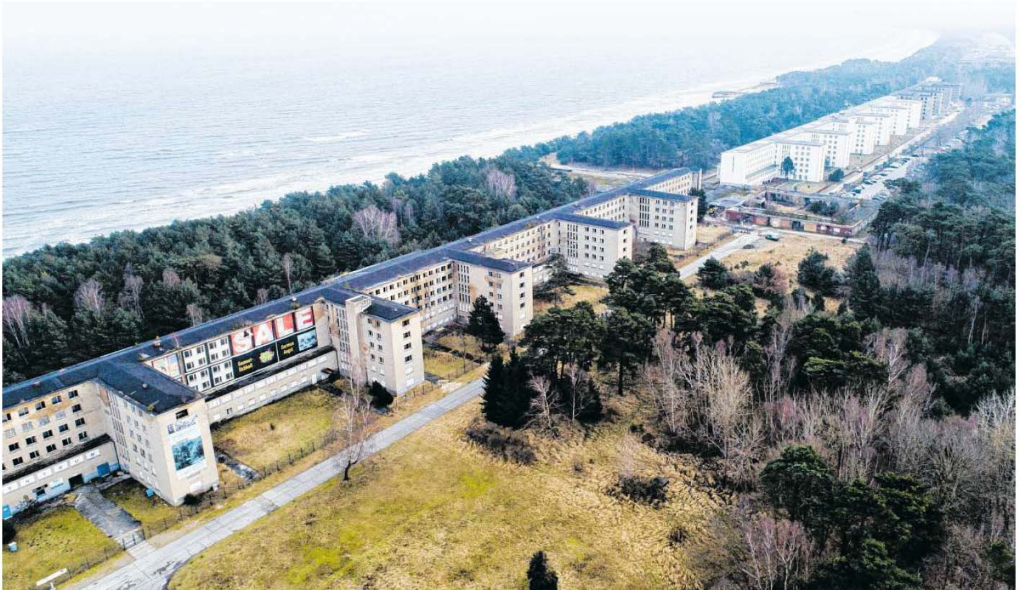
Blick auf Block V im denkmalgeschützten Komplex in Prora. Der Kreis will den Block verkaufen.
