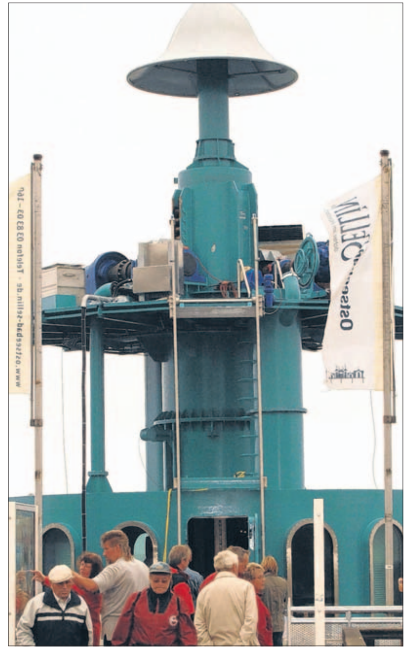
Die Tauchgondel, die zweite nach der in Zinnowitz, wird gegenwärtig am Kopf der Selliner Seebücke montiert. Foto: KÜMA
