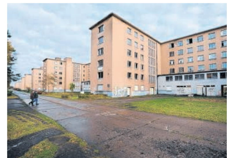
In der ehemaligen NS-Ferienanlage in Prora waren bis 1990 auch Bausoldaten kaserniert. Nun entsteht dort eine Jugendherberge. Foto: dpa
