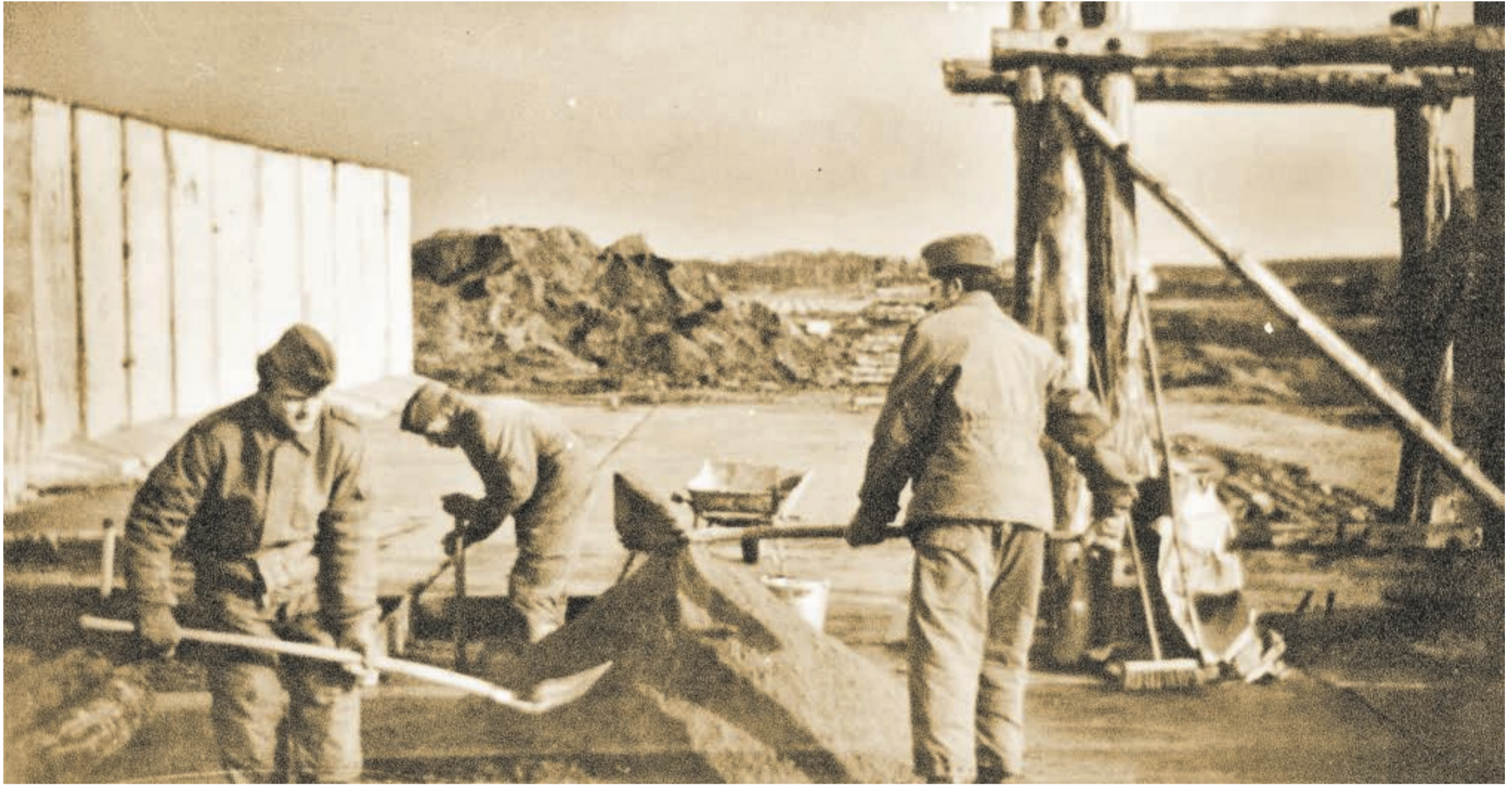
Bausoldaten mussten Militäranlagen errichten, wie hier 1974 den NVA-Flugplatz Holzdorf bei Herzberg (Brandenburg), aber auch in der DDR-Volkswirtschaft ausshelfen.
