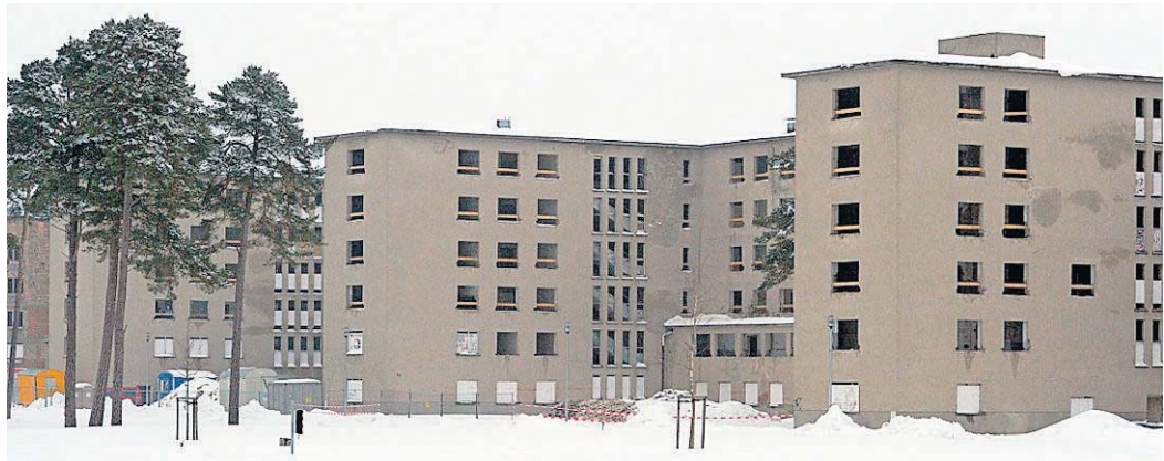
BLOCK 5 des „Koloss von Prora“, wo auch die Bausoldaten untergebracht waren, wird seit einigen Monaten zur Jugendherberge umgebaut. Foto: dpa
